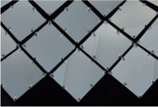
図44 4mm スワロフスキーによるミラーの留め付け
